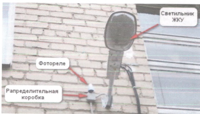
Рисунок 8. Принципиальная схема подключения фотореле и пример установки фотореле
