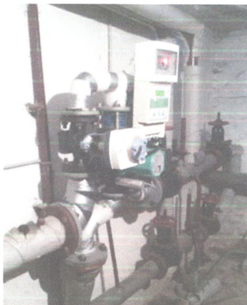
Рисунок 18. Пример монтажа СУАПР (система отопления жилого 5-ти этажного дома)
