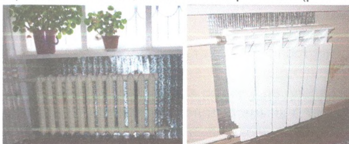
Рисунок 11. Отражающая теплоизоляция, установленная за радиатором отопления
